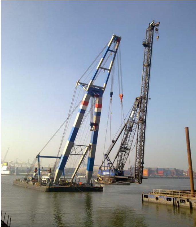
Figuur 5.8 Hei-installatie wordt met een drijvende bok op een ponton geplaatst
