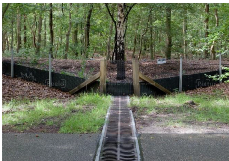
Figuur 43: voorbeeld van een hekwerk waarlangs een kunststof amfibiescherm is geplaatst (bron: ATKB, 2012)
