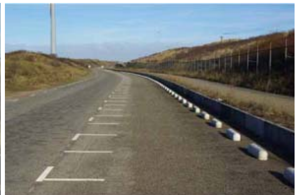
Figuur 3.4 Haakse parkeerplaatsen aan de Reyndersweg
