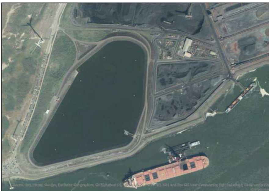
Afbeelding 4.9 Luchtfoto van de huidige situatie rondom het slibdepot en het opslagterrein van Tata Steel
