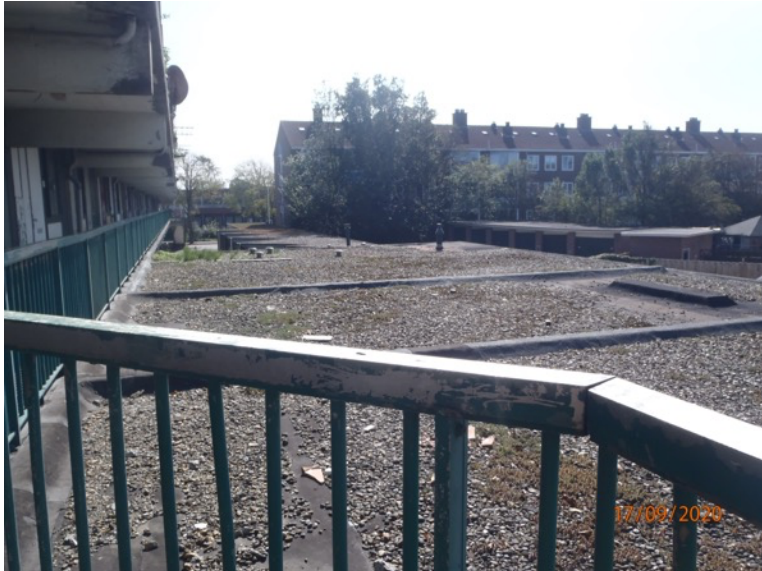
Afbeelding 7. Flatgebouw zicht op het dak van de garages
