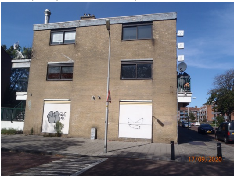
Afbeelding 8. Flatgebouw zicht op de zuidzijde
