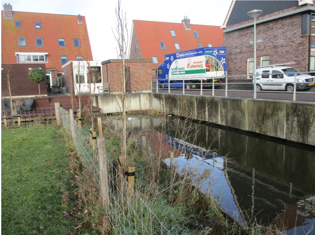
Figuur 3 De planlocatie is aan de noord- oost- en zuidzijde omringt door sloten met een steile beschoeiing.
