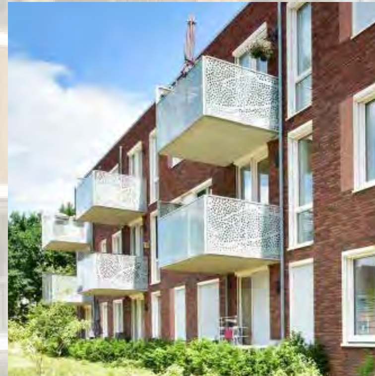
balkons zijn ontworpen in relatie met de architectuur, zorg voor privacy door goed gekozen hekken
