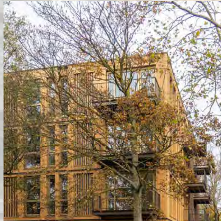
De dakrand loopt rondom het gebouw door (en een terugliggende verdieping ligt daar achter)
