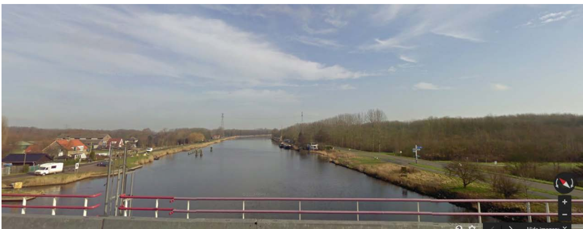
Figuur 9 Zicht in noordelijke richting over het kanaal vanaf het viaduct van de A9.
