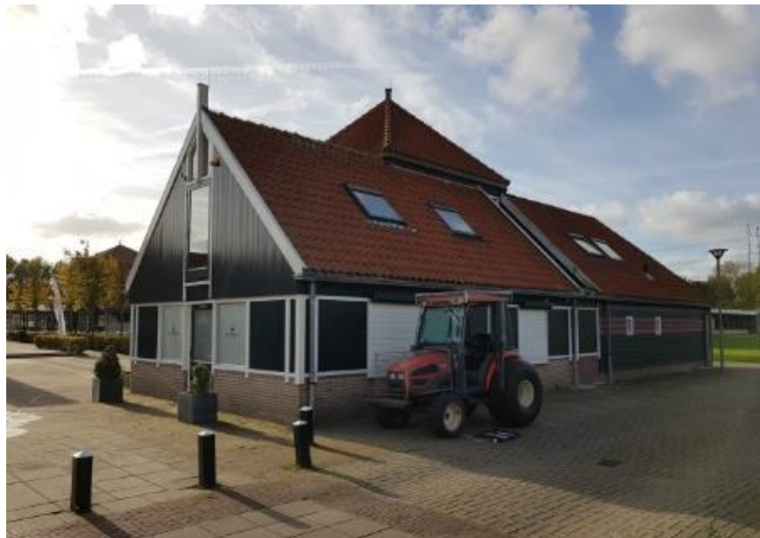
Figuur 3: Zuidelijke te slopen gebouw
