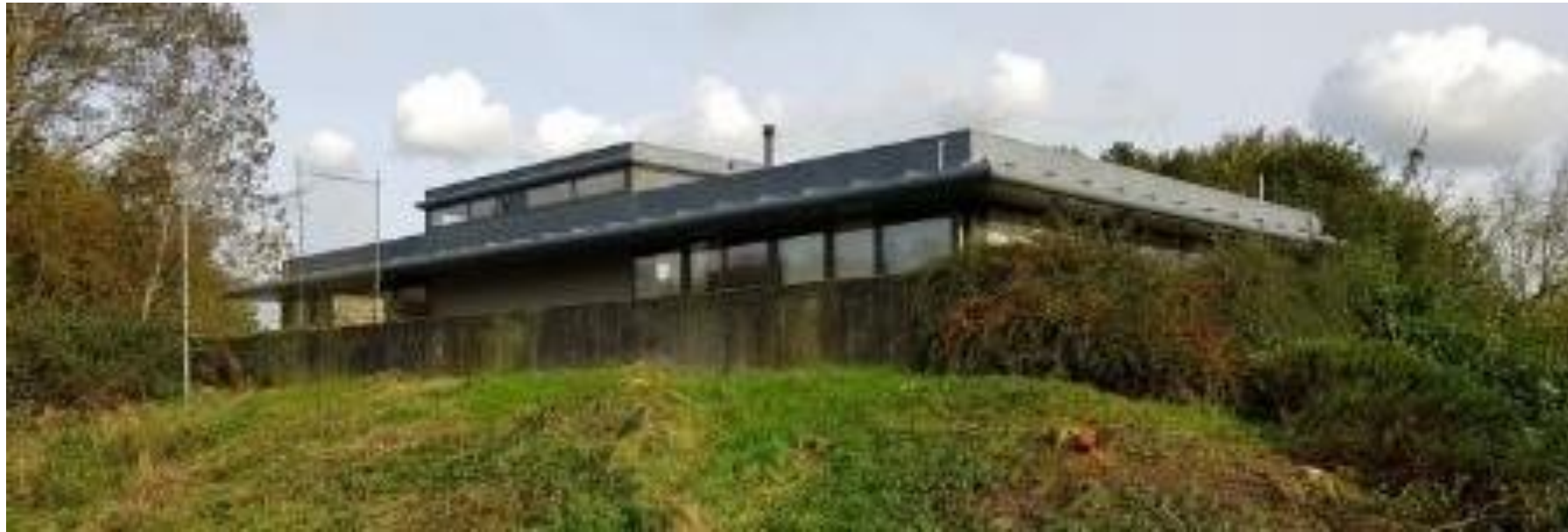
Figuur 1: Noordelijke te slopen gebouw
