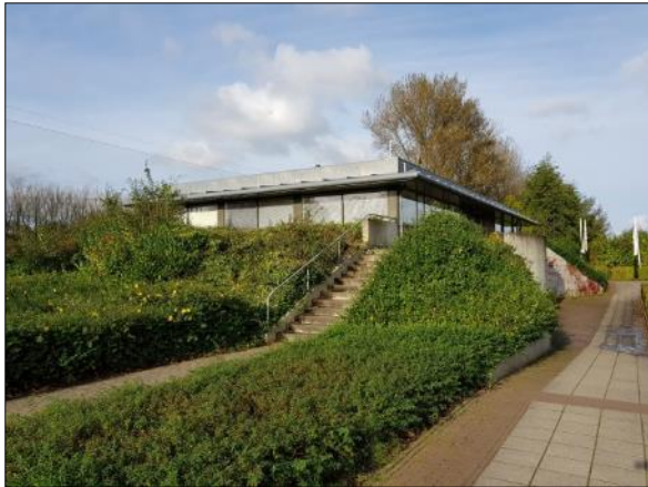
Figuur 7. Betonnen gebouw met plat dak
