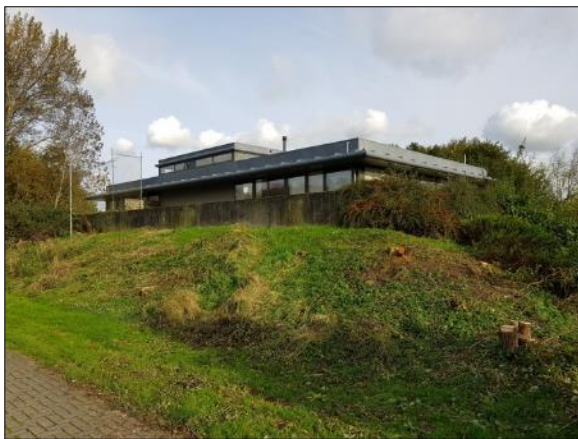
Figuur 9. Achterzijde gebouw met platdak
