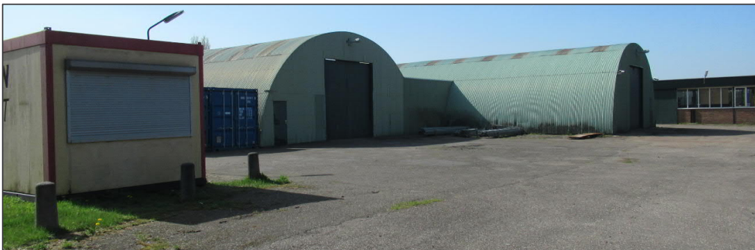
Figuur 8 De uit 1987 daterende loodsen. Rechtsachter het gebouw uit 1964
