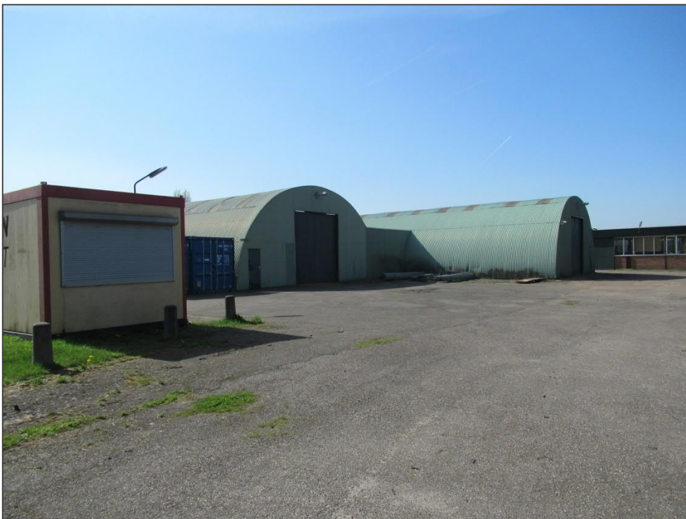
Figuur 10 Te slopen loodsgebouwen ter plaatse van Hofgeesterweg 18a.
