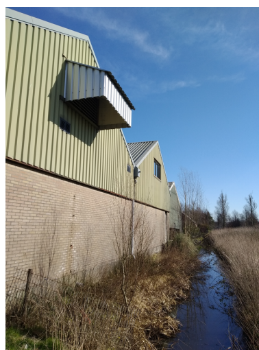
f6.1 Ventilatiooster compressorruimte (links) en condensoruimte (rechts)
