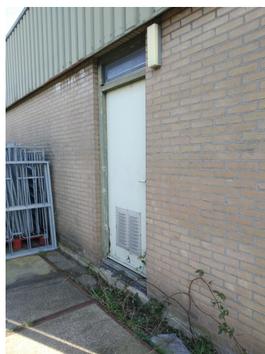
f6.1 Ventilatiooster compressorruimte (links) en condensoruimte (rechts)
