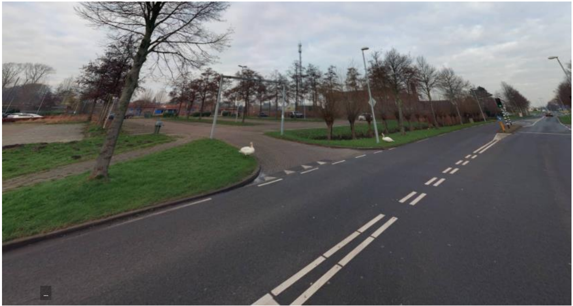
Figuur 1.4: De huidige aantakking van de parkeerplaats P2 op de Vlietweg
