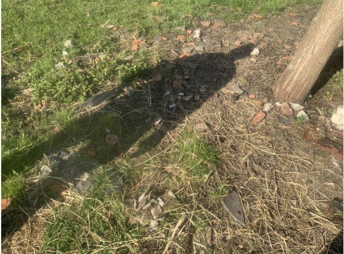
Foto 1: puin en asbestverdacht materiaal op maaiveld
