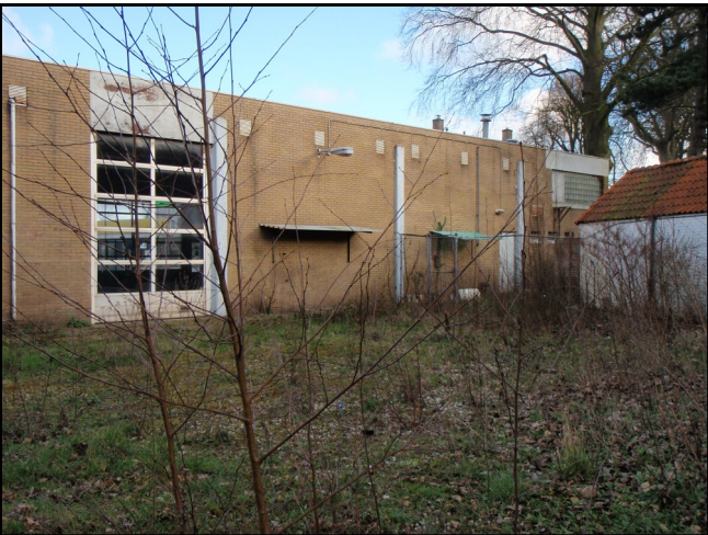
Foto 9: Zicht op voormalige bovengrondse tank voor afgewerkte olie
