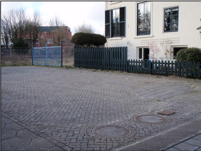
Foto 1: Overzicht belending nr. 252, achterterrein en gesaneerde ondergrondse tanks en OWS
