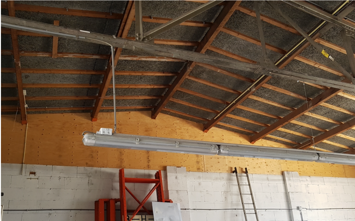
Afbeelding 6. Het dak van de loodsen aan de binnenzijde; er zijn geen holle ruimtes onder het dak aanwezig
