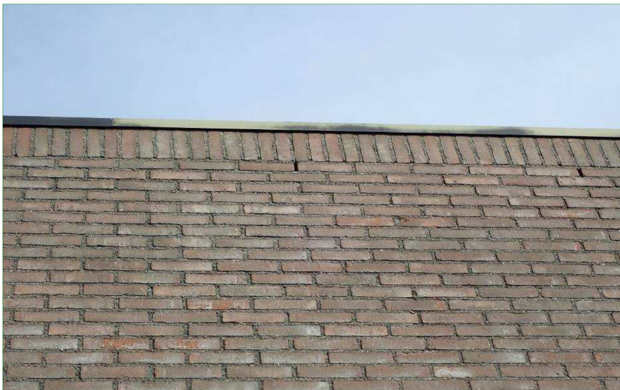
Stootvoegen in de zuidmuur van de bebouwing. Alle in de bebouwing aanwezige stootvoegen geven mogelijk toegang tot voor vleermuizen geschikte verblijfplaatsen.
