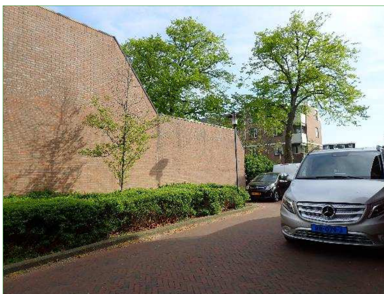
Blinde gemetselde muren zijn aanwezig.
