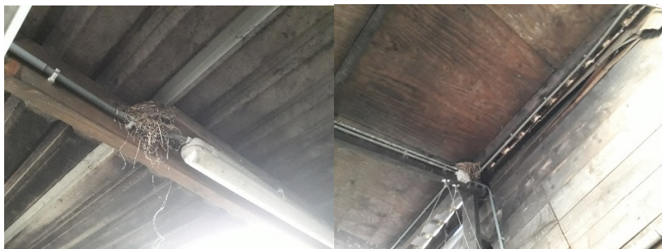
Figuur 4.2: Er zijn meerdere nestlocaties van de boerenwaluw in de stallen in het projectgebied aangetroffen.
